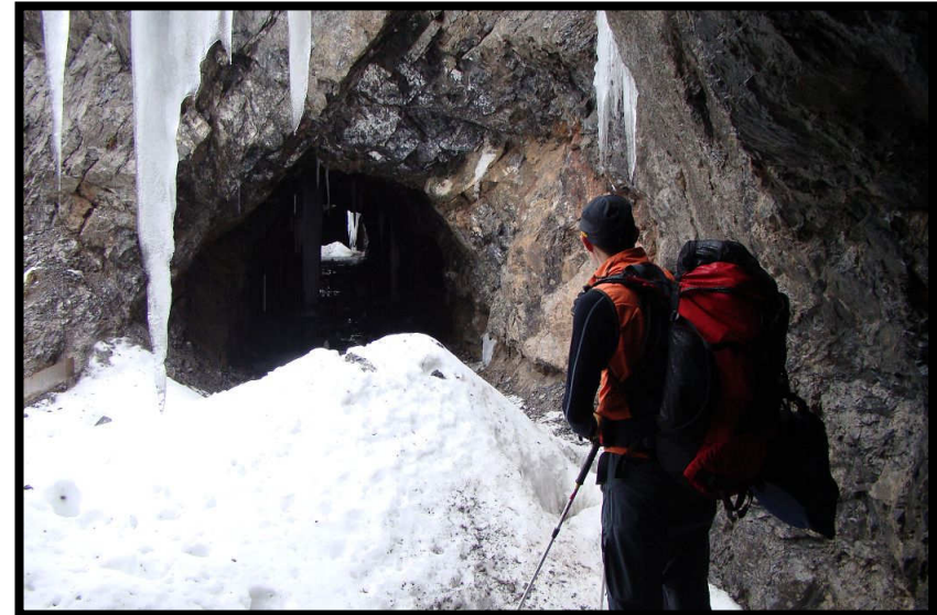
Die Tunnel vor der Sulzelalm.
