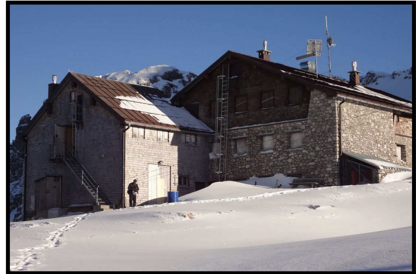
Fiderepasshütte, oben links ist der Winterraum.
